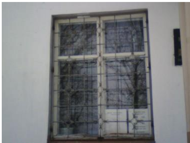
Рис. П.6. Наружные ограждающие конструкции в хорошем состоянии, температурные перепады связаны с нарушением переплетов оконных проемов.
