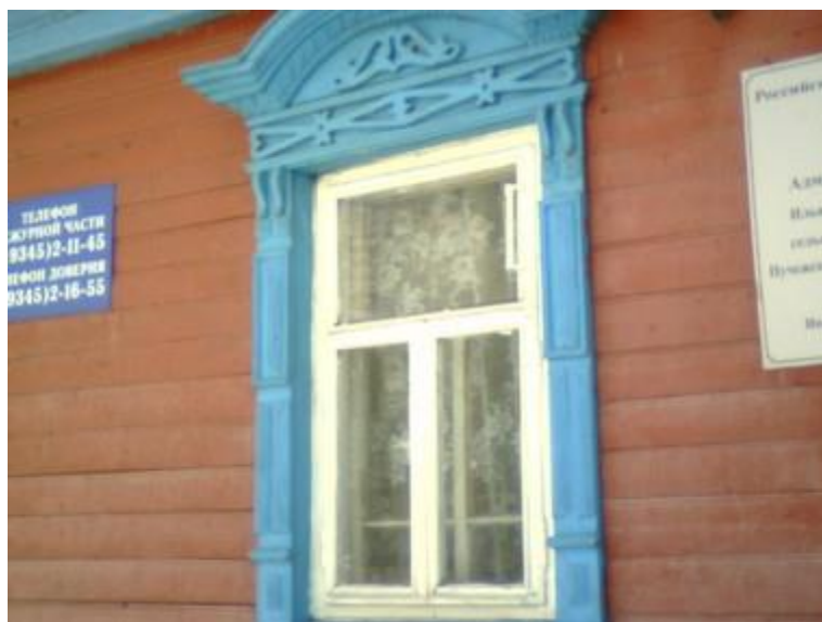
Рис. П.3. Наружные ограждающие конструкции в хорошем состоянии, температурные перепады связаны с нарушением переплетов оконных проемов.
