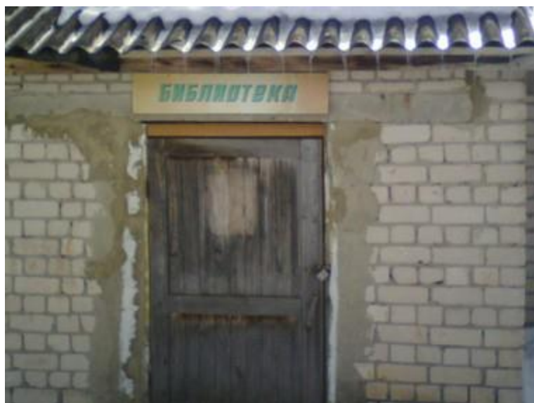
Рис. П.11. Наблюдается температурный перекоп в районе дверного проема.
