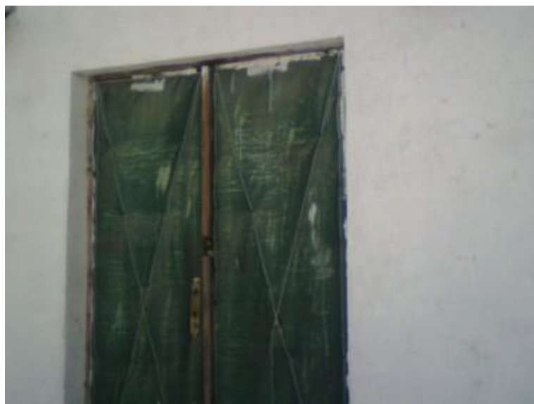
Рис. П.8. Наружные ограждающие конструкции в хорошем состоянии, температурные перепады связаны с неплотным примыканием дверного полотна.
