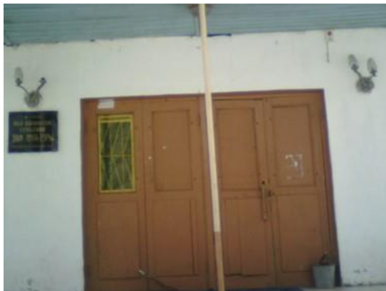
Рис. П.5. Наружные ограждающие конструкции в хорошем состоянии, температурные перепады связаны с неплотным примыканием дверного полотна.
