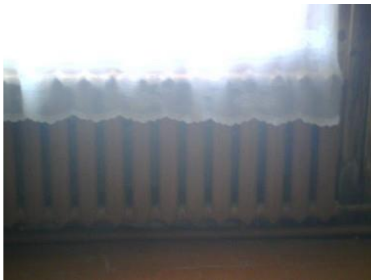
Рис. П.14. Наблюдается равномерное распределение тепла в приборе отопления, что говорит об отсутствии внутренних загрязнений радиатора.
