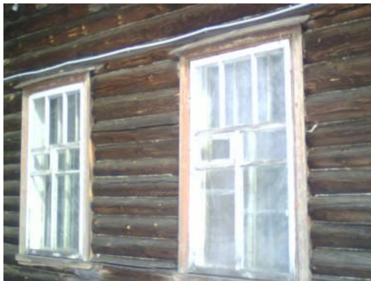
Рис. П.13. Наружные ограждающие конструкции в хорошем состоянии, температурные перепады связаны с нарушением переплетов оконных проемов.
