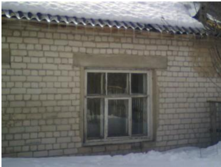
Рис. П.10. Наружные ограждающие конструкции в хорошем состоянии, температурные перепады связаны с нарушением переплетов оконных проемов.
