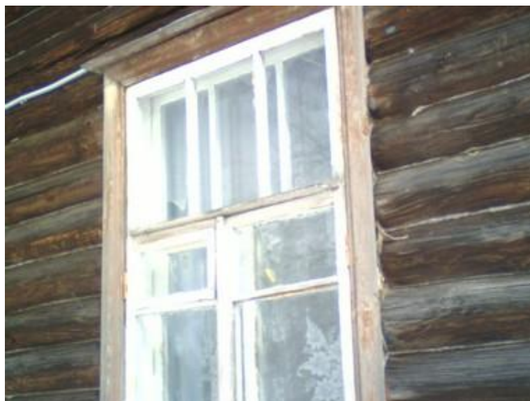
Рис. П.12. Наружные ограждающие конструкции в хорошем состоянии, температурные перепады связаны с нарушением переплетов оконных проемов.
