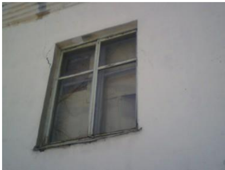
Рис. П.7. Наружные ограждающие конструкции в хорошем состоянии, температурные перепады связаны с нарушением переплетов оконных проемов.
