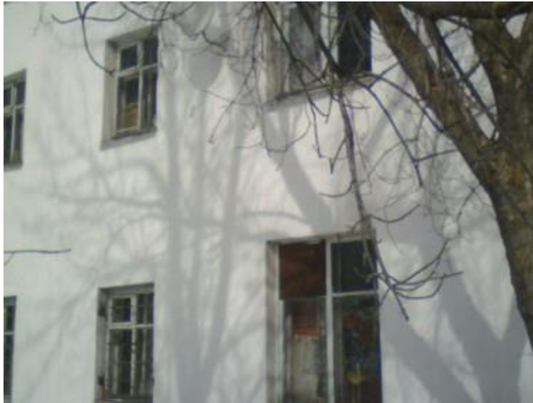
Рис. П.9. Наружные ограждающие конструкции в хорошем состоянии, температурные перепады связаны с нарушением переплетов оконных проемов.
