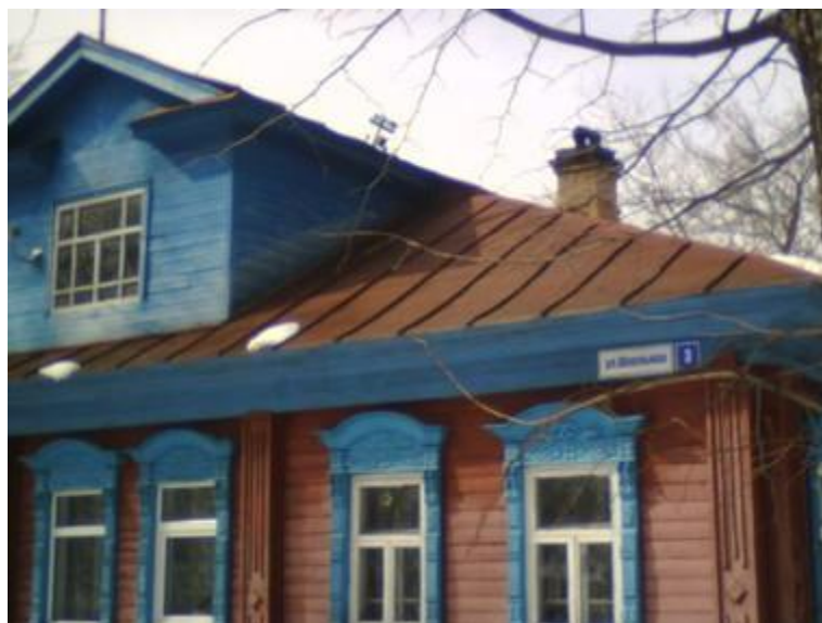
Рис. П.4. Наружные ограждающие конструкции в хорошем состоянии, температурные перепады связаны с нарушением переплетов оконных проемов.
